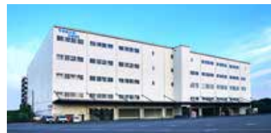
(株)東京ロジテック 本社倉庫(西多摩郡瑞穂町)
